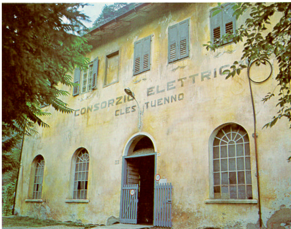
La centrale idroelettrica di S.Emerenziana 1 prima della recente ristrutturazione
